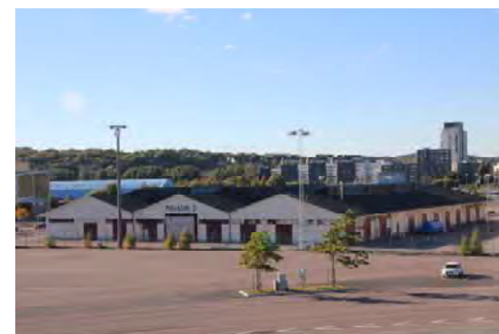
Byggnad 6, magasin D.
