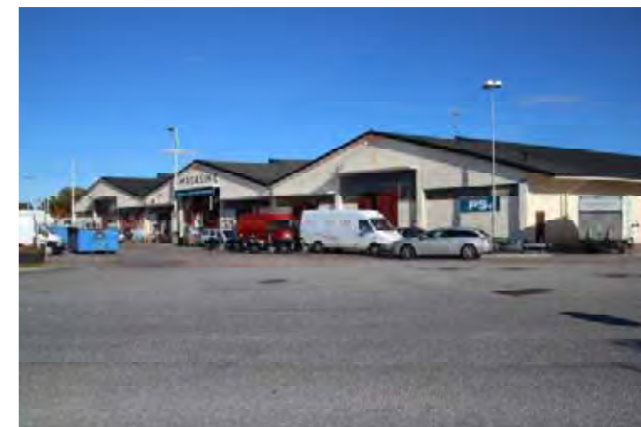
Byggnad 5, magasin E.
