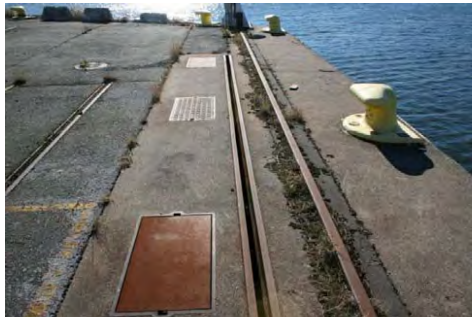
5. Pollare Längs med flera av kajkanterna finns pollare bevarade. De bidrar såväl till upplevelsen av hamnmiljön som till läsbarheten, och är av stor betydelse för den bibehållna kontinuiteten i området.
