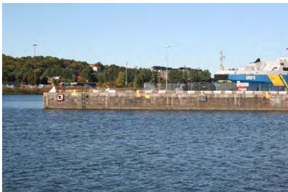
13. Stenskodda kajer Bananpirens norra sida och Norra frihamnspirens södra sida är uppförda i sten och ger ett gediget intryck. Stenkonstruktionen ger en koppling till tiden före betongens intåg i hamnen och bidrar till den estetiska upplevelsen på platsen.
