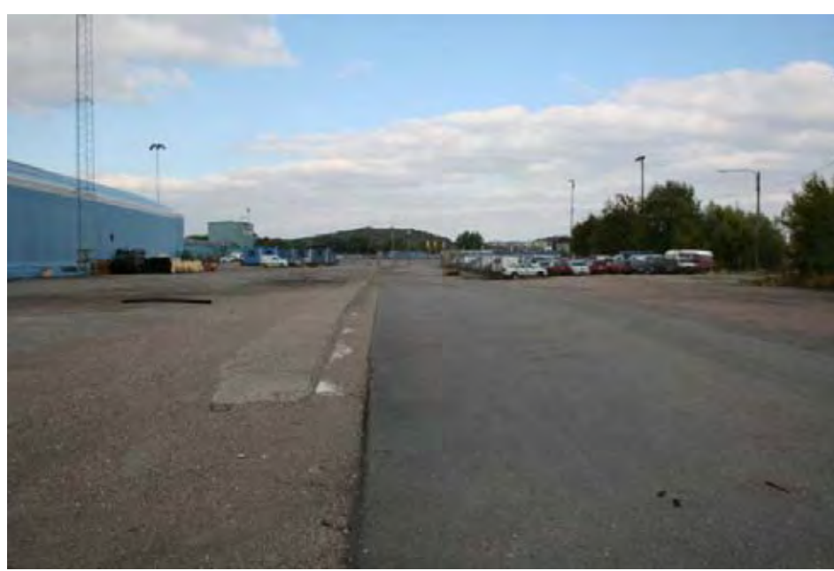
17. Betongsträngar På Kvillepiren och i stora delar av det inre av hamnen ligger betongspår ned-sänkta i asfalten. De har fungerat som förstärkningar för att tunga lastbilssläp inte skall sjunka ned i asfalten.
