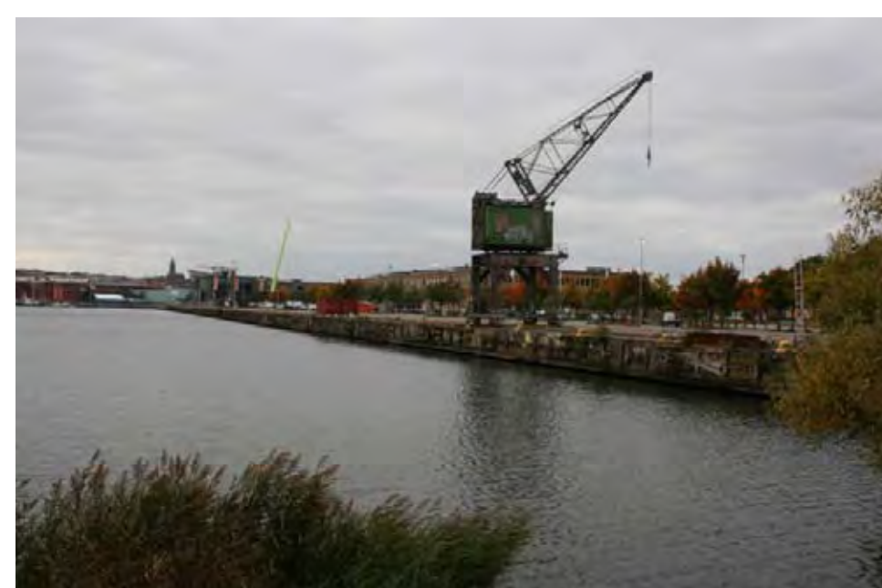
18. Kran i Lundbyhamnen ★ I Lundbyhamnen finns områdets enda kvarvarande kran. Just denna kran har inte någon längre historia på platsen, då den är hitflyttad från Gullbergsvass, men den ger en bild av hur det en gång sett ut i området och bidrar till upplevelsen av hamn och verksamhet. På så vis ökar den också områdets läsbarhet.
