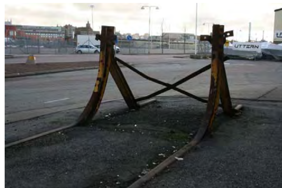
15. Stoppbock ● Invid kajskjul 113 finns en stoppbock i järn. Stoppbockarna minner om en period då tågtrafiken i området var livlig och stora mängder gods transporterades hit med järnväg. Den ger en direkt påminnelse om områdets historia och är av stor betydelse för förståelsen och läsbarheten i miljön som helhet.
